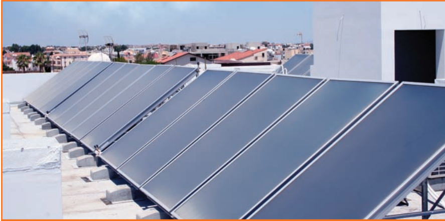
Κέντρο υποστηριζόμενης διαβίωσης ΑΡΗΤΗ - Στρόβολος
